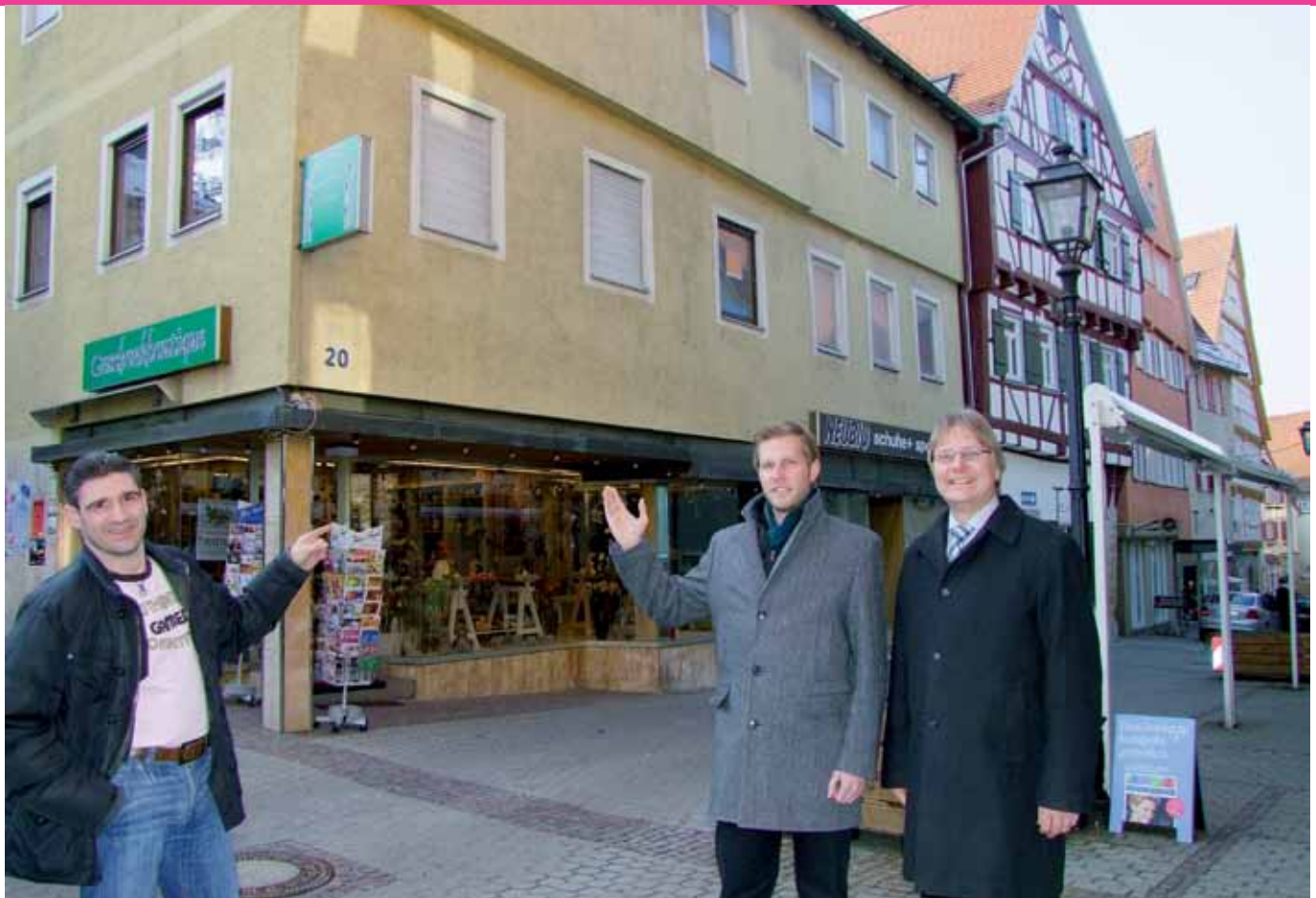
Frank Wengert, Timo und Roland Heim vor dem neuen Sanierungsobjekt in der Obertorstraße in Brackenheim
