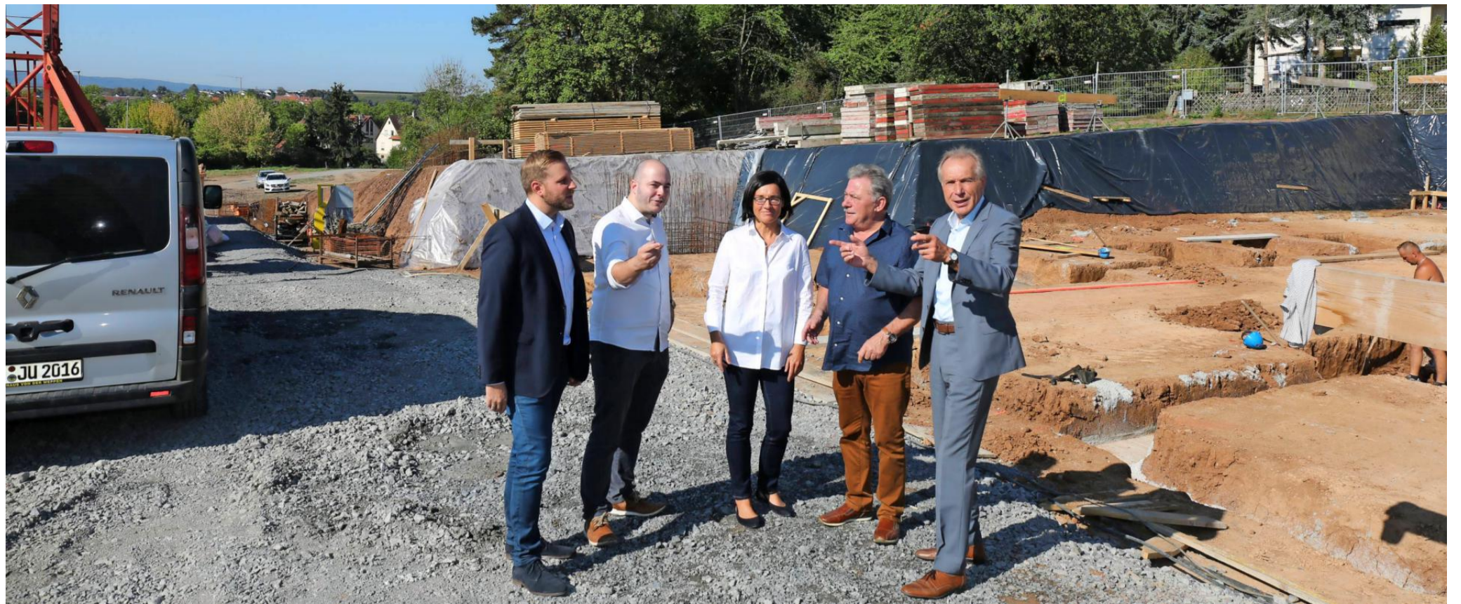
Timo Heim (zuständig für Verkauf), Alexander Koller (Bauleitung), Beate Piehler (Bauleitung), Alfred Koller (p.b.s.-Geschäftsführer) und Bürgermeister Rolf Kieser (von links) vor der Baugrube.
